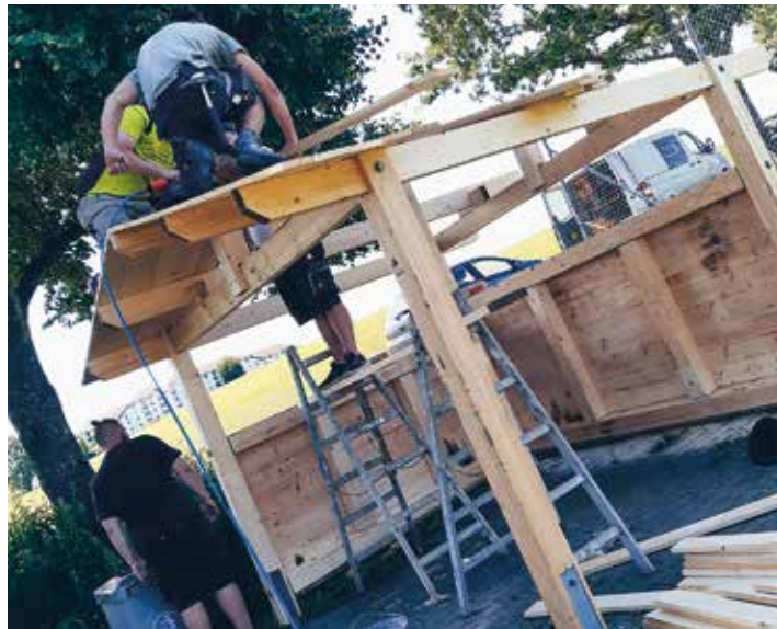
Gemeinsam wurde tatkräftig angepackt, um die Hütte am Spiel- und Bolzplatz zu renovieren.
